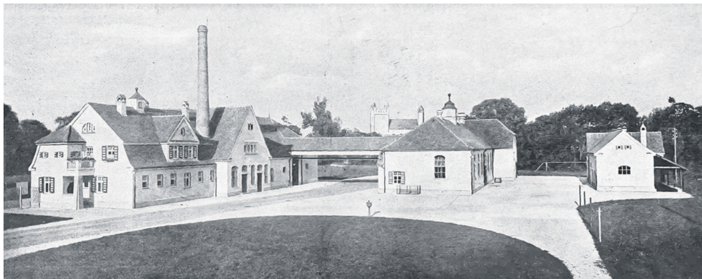
Gesamtansicht des Schlachthofkomplexes: Links Hallenmeisterwohnung und Warmbad, dahinter Kessel- und Maschinenraum; im rechten Gebäudeteil befand sich die Schlachthalle, im freistehenden kleinen Gebäude ganz rechts war lange Zeit die Freibank untergebracht, Fotografie, Der Industriebau, Jg. 1911, Bayerische Staatsbibliothek
