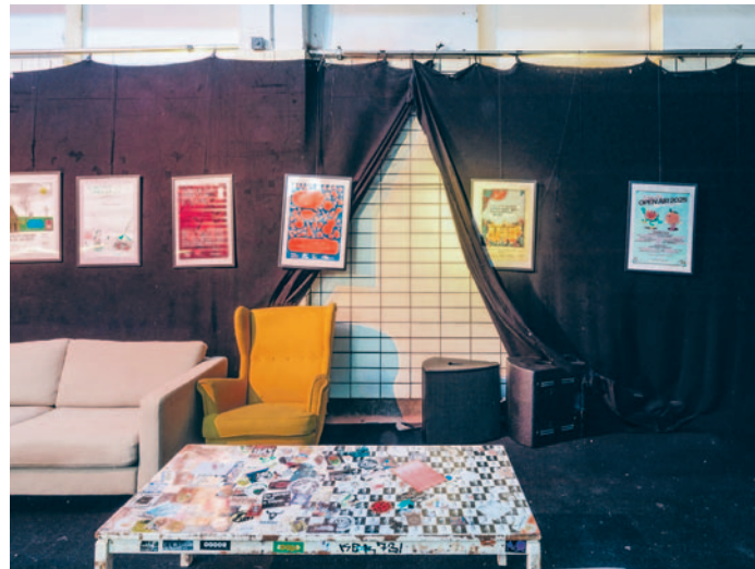
Klang statt Kacheln: Heute sind die gekachelten Wände mit schwarzem Molton verhängt. Dadurch kann die Akustik verbessert werden, während die denkmalgeschützte Bausubstanz darunter erhalten bleibt, 2026, Foto: Wolfgang Pulfer, Fürstenfeldbruck
