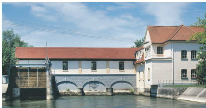
Bild: © Stadtwerke Fürstenfeldbruck: Wasserkraftanlage Schöngeising – das zweitälteste Wasserkraftwerk in Deutschland und seit mehr als 130 Jahren im Betrieb
