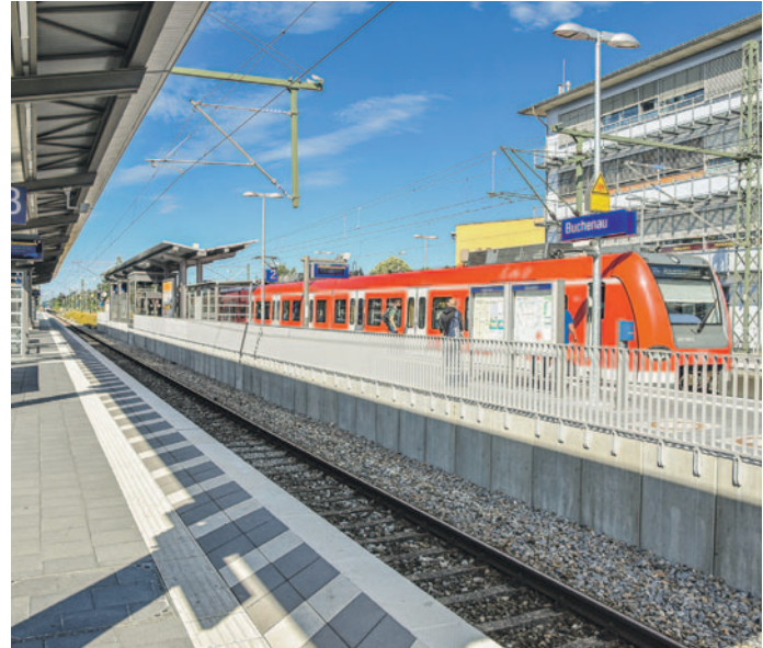
Das Wendegleis am Bahnhof Buchenau soll für die neuen Züge 70 Meter länger werden.
